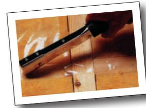
Fixation des écrans sous-toitures.
