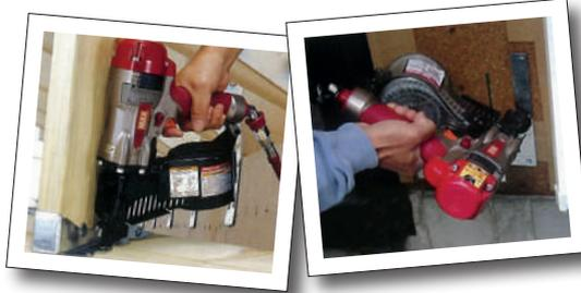
Fixation des sabots / connecteurs métalliques.
